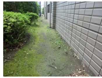
よく整備された建物周り
