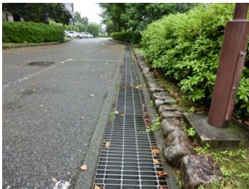
排水溝と植え込み
